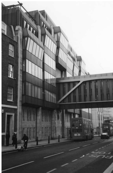
CSO Head Office, London UK.
